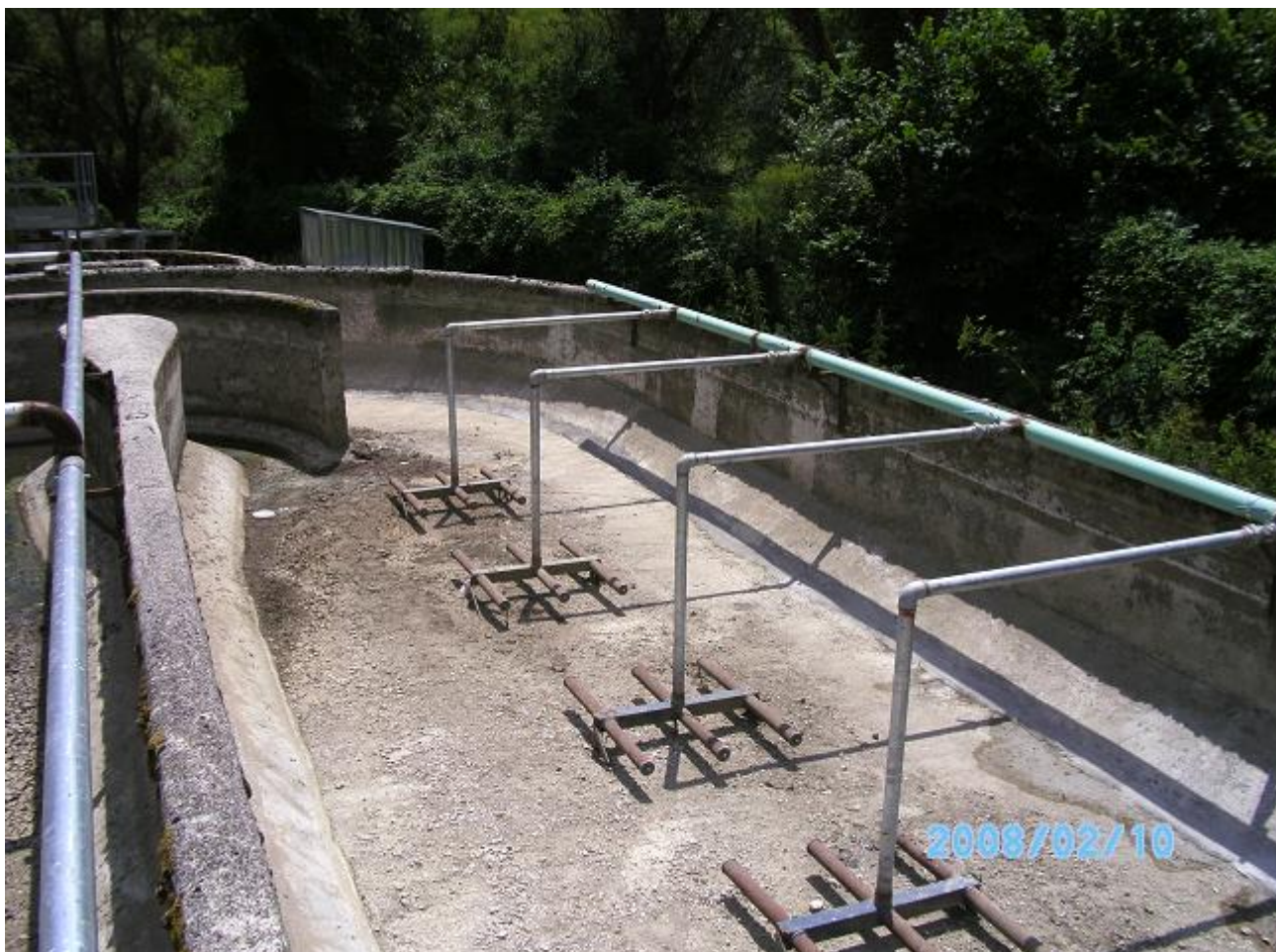
Figura 2 Impianto di Castellafiume: diffusori ceramici tubolari
