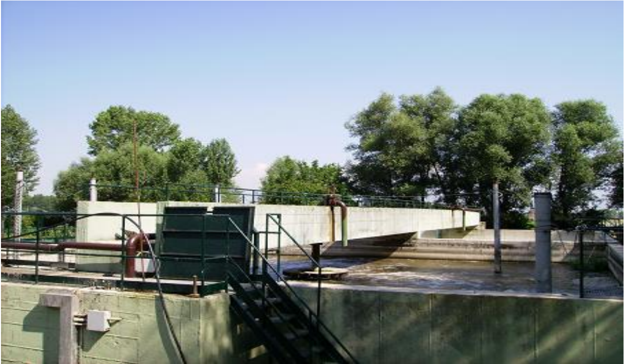
Impianto di Trasacco: flo-jet in sostituzione di tubina superficiale guasta.
